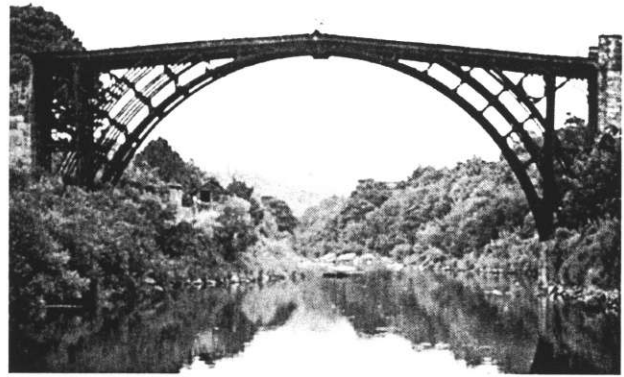
Abb. 3. Die erste Gusseisenbrücke der Welt: Coalbrookdale 1779. Beispiel für neue Anwendungen, die neue Werkstoffe und ihre Erzeugungsverfahren ermöglichen.
